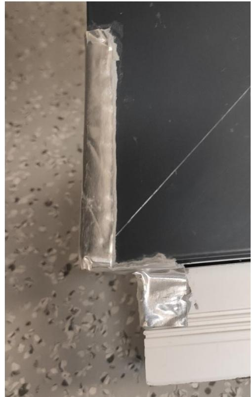
Später wird die Putzleiste nicht auf das Butylband, sondern seitlich daneben aufgeklebt.
