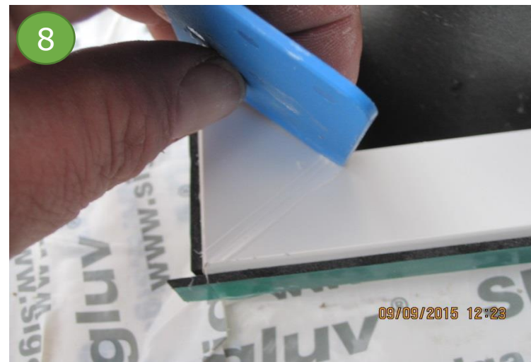
mit Zitrusreiniger Klebereste entfernen und mit Klebeband die Eckverbindung abdichten
