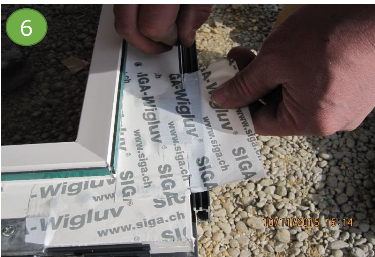
mit Zitrusreiniger Klebereste entfernen und mit Klebeband die Eckverbindung abdichten
