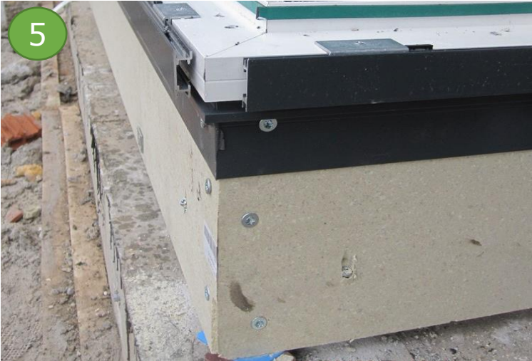
Thermoausgleichsprofile über Eck verschrauben
