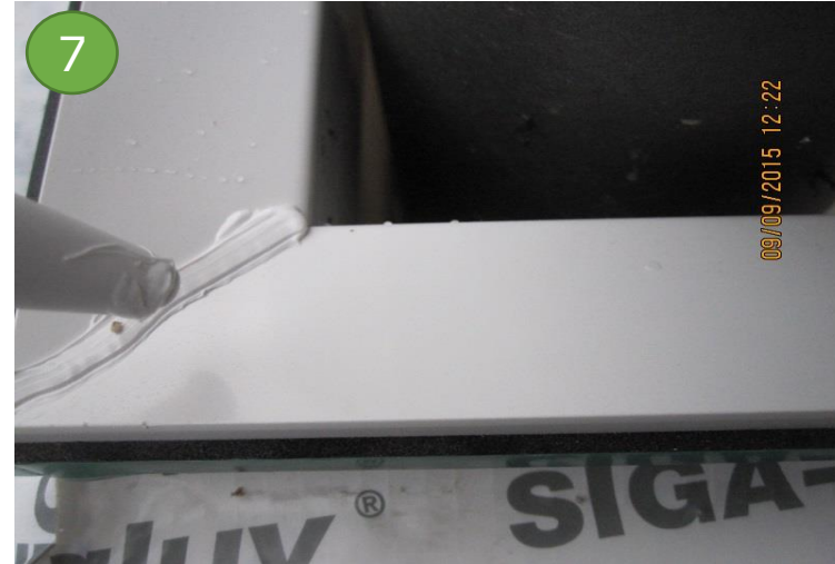
Innenfuge mit Ramsauer 640 Dichtkleber versiegeln
