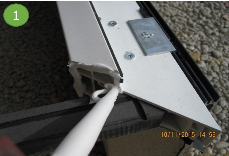
Gehung mit Ramsauer 640 Dichtkleber versiegeln.
