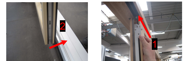
Abb. 3: Einhängen des Flügels
