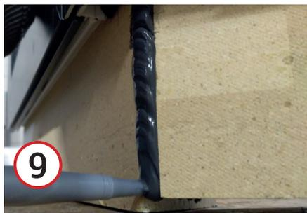
9. Spalt mit Dichtkleber<sup>\*1</sup> versiegeln
