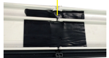
Koppelungsbereich mit Alubutylband (nicht im Set enthalten) abkleben
