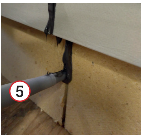
5. Spalt mit Dichtkleber* 1 versiegeln
