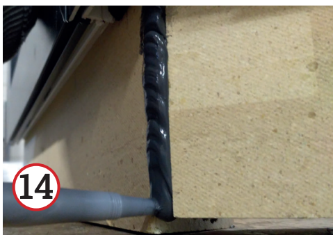
14. Spalt mit Dichtkleber*1 versiegeln
