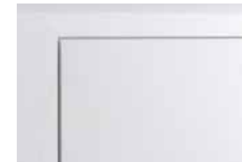
Bündige, verputzte Zarge liegt „unsichtbar“ in der Wand
