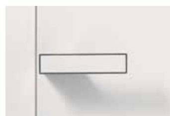
MET 56: Die Zarge liegt verputzt und „unsichtbar“ in der Wand
