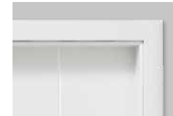
Rückseite mit sichtbarem Falz an der Verkleidung und ohne Spalt
