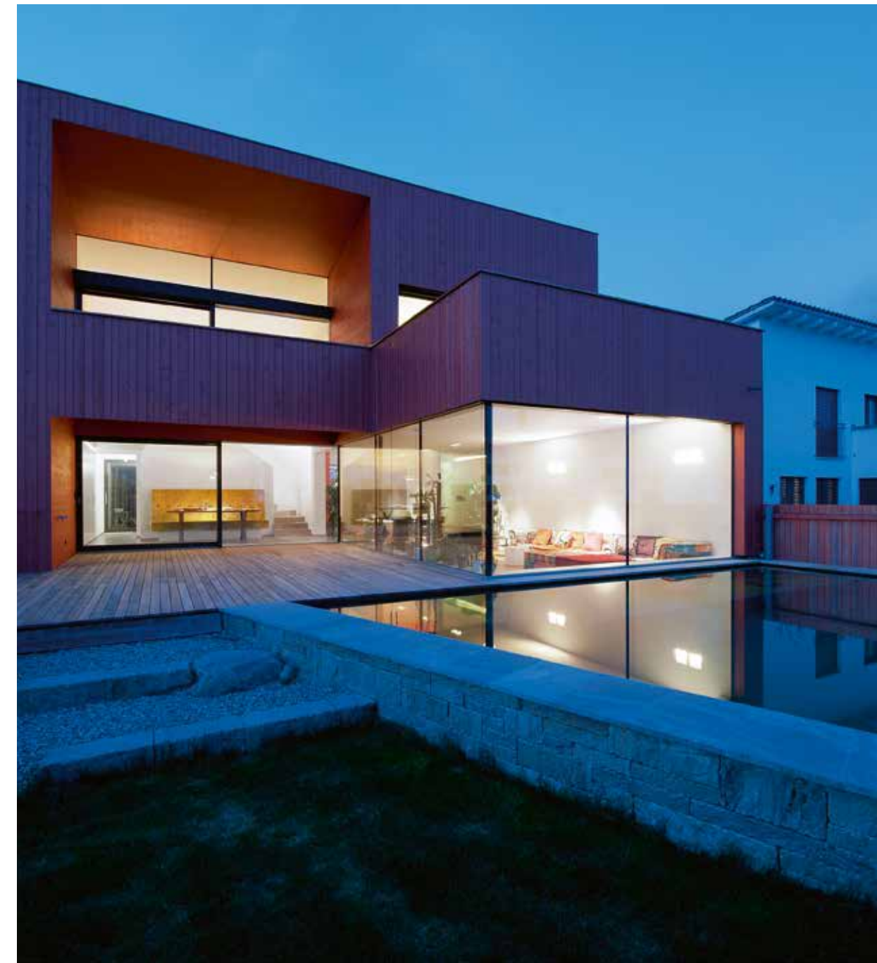
Architekt: Heim und Kuntscher, Architekten BDA Foto: Dietmar Tollerian
